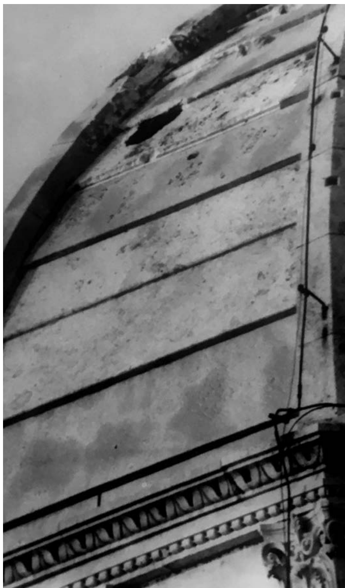
Kupola katedrale Sv. Jakova, Šibenik, Hrvatska / The Dome of the Cathedral of St. James, Šibenik, Croatia Građena 1431.-1536. / Built 1431-1536 / Oštećena 16. 09. 1991. / Damaged on September 16, 1991 Od 2000. godine uvrštena je na UNESCO-ov popis svjetske kulturne baštine Since 2000 on the UNESCO World Heritage List Foto: Konzervatorski odjel Šibenik (Ministarstvo Kulture RH, UZKB –F) Photo: Conservation Department Šibenik (Ministry of Culture of the Republic of Croatia, UZKB –F)
